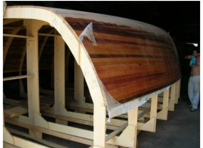
RIVESTIMENTO CON STUOIA 200 GR/MQ E RESINA EPOSS
