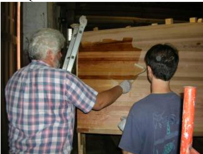
RIVESTIMENTO CON STUOIA 200 GR/MQ E RESINA EPOSS
